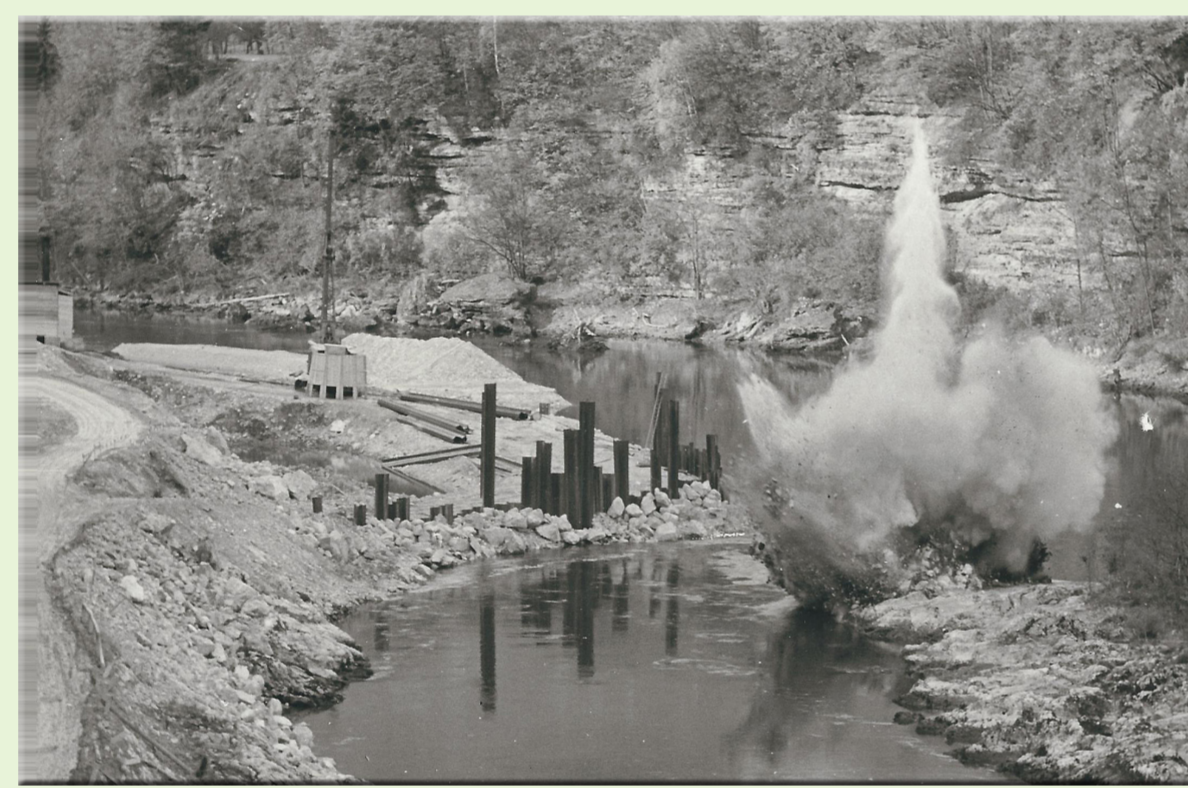
Sprengung am Flößerfreithof beim Bau des Auslaufkraftwerks in Kuppfern um 1960
